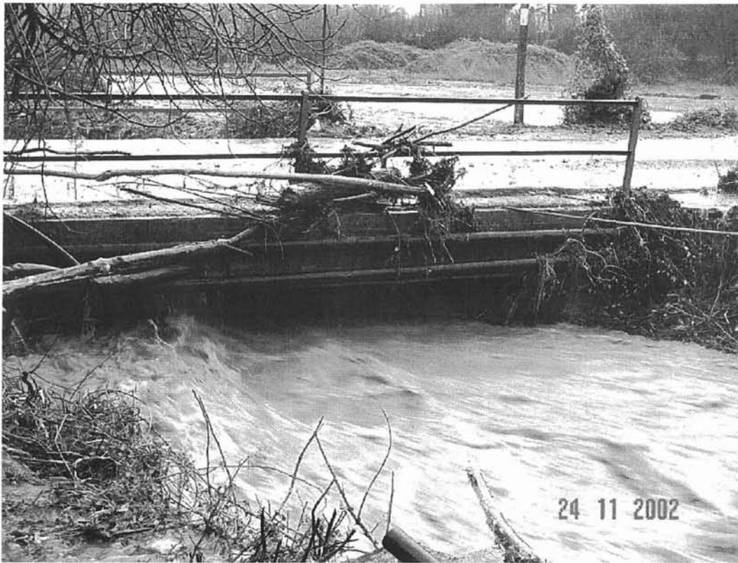
FIG. 6 - Esempio di riduzione della sezione di deflusso del reticolo idrografico minore a seguito dell'evento alluvionale.
