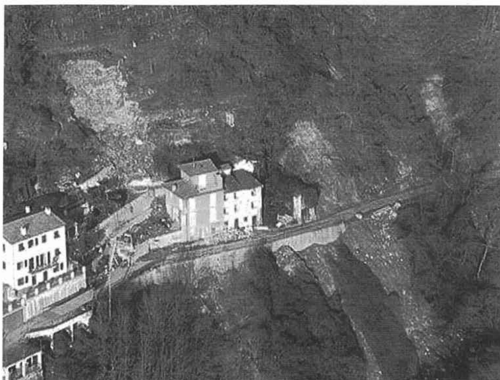
FIG. 5 - Dissesto in località Villa Cuneo innescatosi in occasione dell'evento alluvionale del 24 Novembre 2002.
