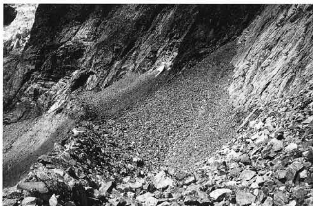
FIG. 13 - Coni detritici colmano il vallo tra versante e morena laterale sinistra del Ghiacciaio di Pré de Bar (Val Ferret, Monte Bianco).
