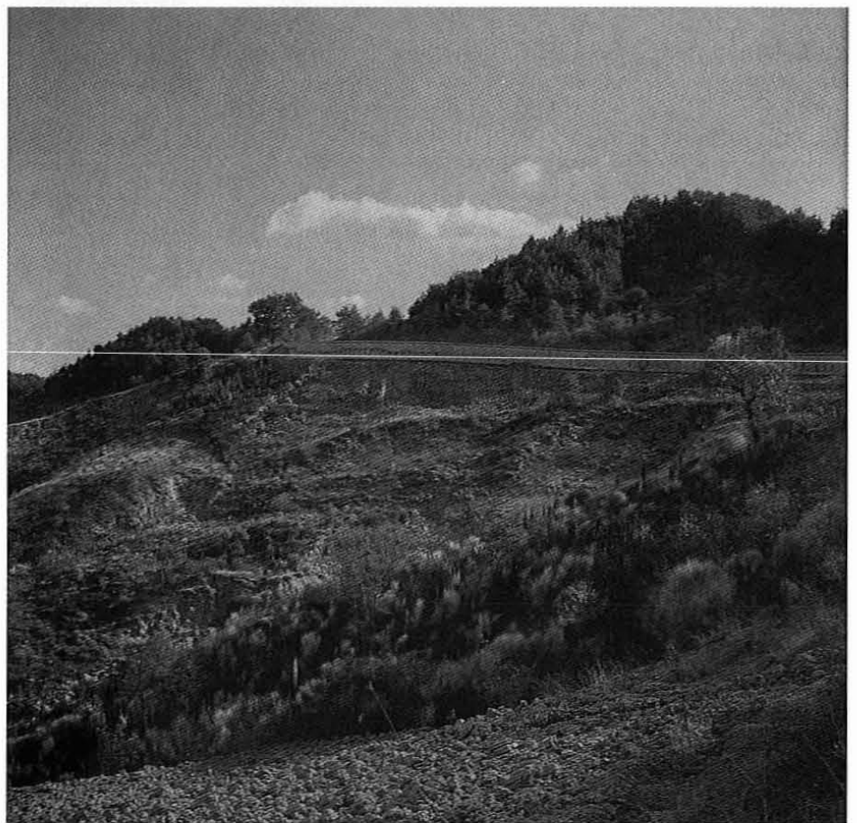
FIG. 2 - Scoscendimento di tipo multiplo nelle argille plioceniche (strada Sforzesca - S. Giovanni delle Contee).
