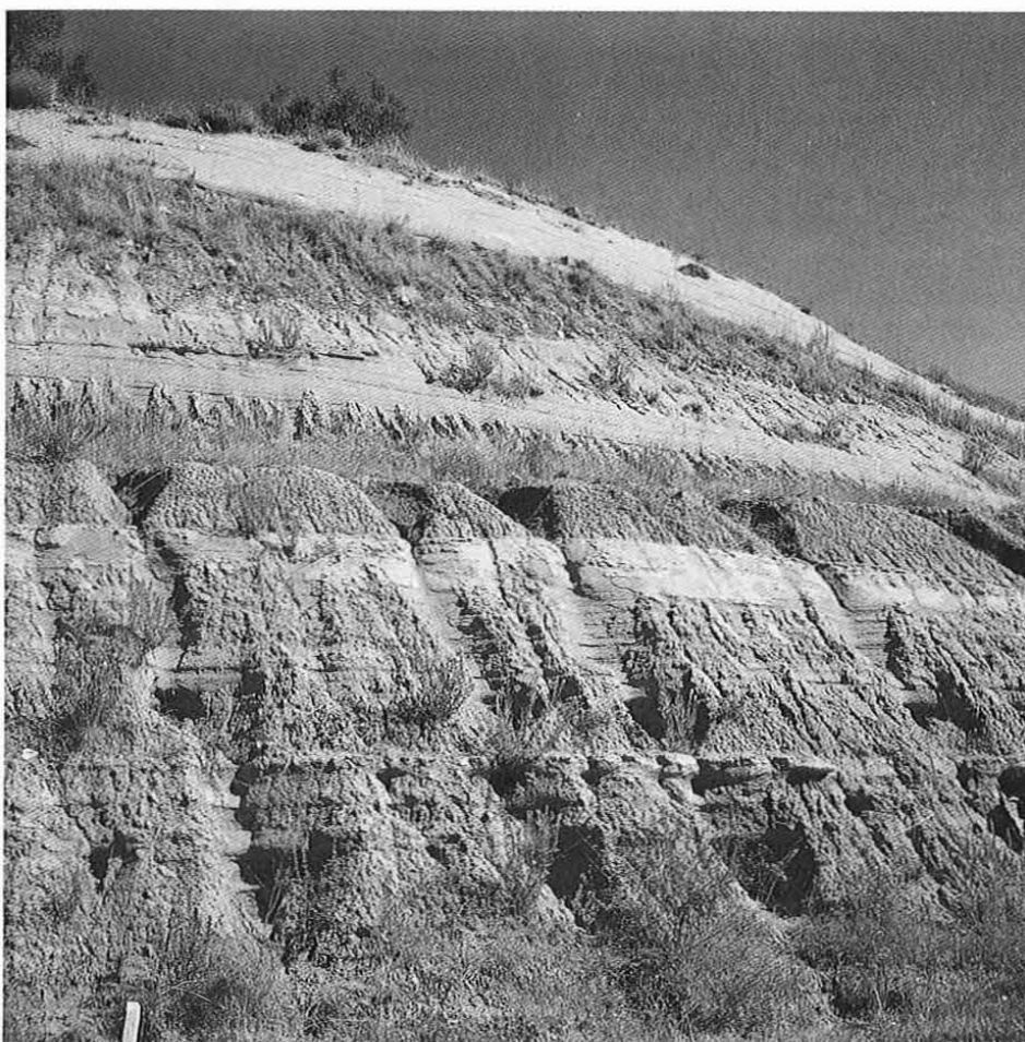
FIG. 4 - Solchi di erosione ( rill ) su sezione di scavo costituita da livelli sabbiosi, limosi e conglomeratici del Pliocene superiore, affioranti lungo la strada Celle sul Rigo - Radiconfani (Poggio al Vento).
